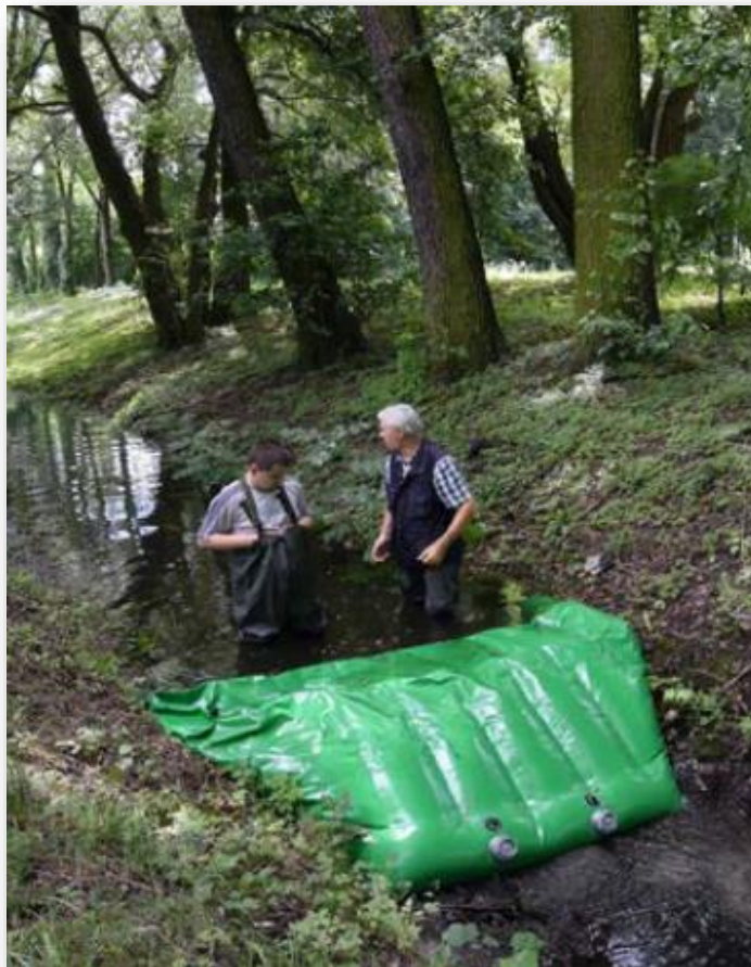
Przenośny próg piętrzący samoczynnie napełniający się wodą płynącą w rowie (źródło: Gospodarowanie wodą w rolnictwie w obliczu suszy, Ministerstwo Rolnictwa i Rozwoju Wsi, Warszawa 2020)
